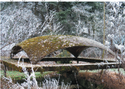
betonschale isler bürogarten
